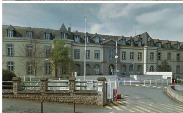
Mise en évidence de l'altération du traitement de la cour jardinée en façade de l'ancien hospice Villedeneu sur comparaison de photographie actuelle et carte postale ancienne.
