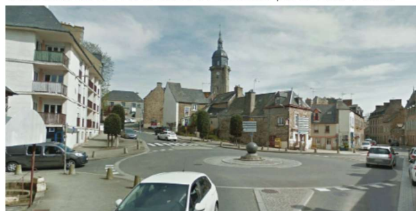
Traitement de la voie d'accès à l'ancienne porte du Boulevard
