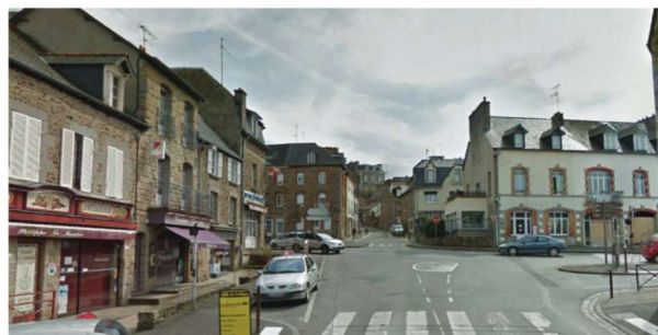
Traitement de la voie d'accès à l'ancienne porte Saint-Martin
