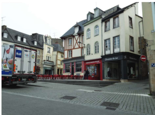
Place du Martray réaménagée, photo actuelle AEI 2019
